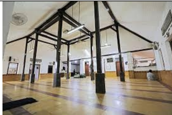
gambar 2. tampak dalam atap joglo masjid lawangsongo setelah direnovasi
