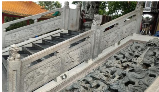
Gambar 6. Railing dengan relief hewan.
